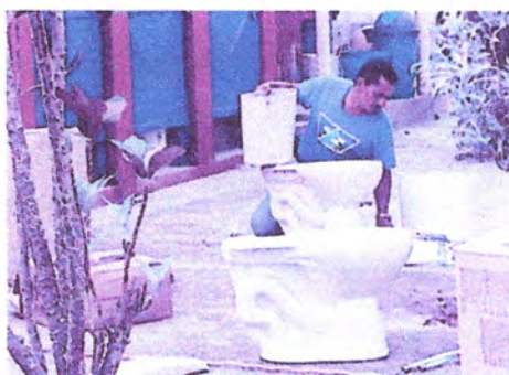
Foto3: Instalación de Sanitarios
