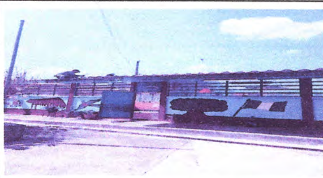
Foto1: Reparación del techo
