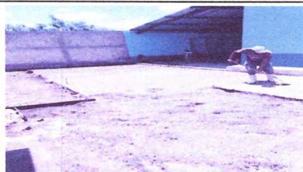
FOTO 2: Reparación Losa de Patio
