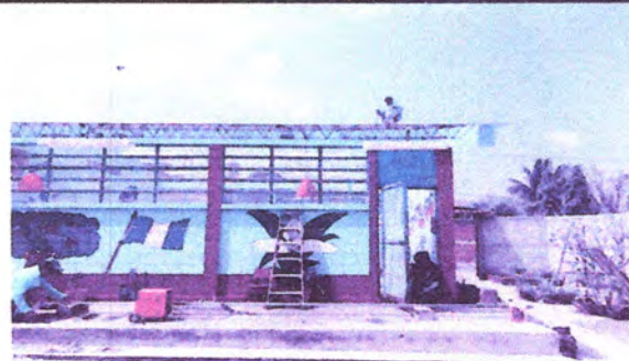
Foto: 6 desmantando techo de duralita
