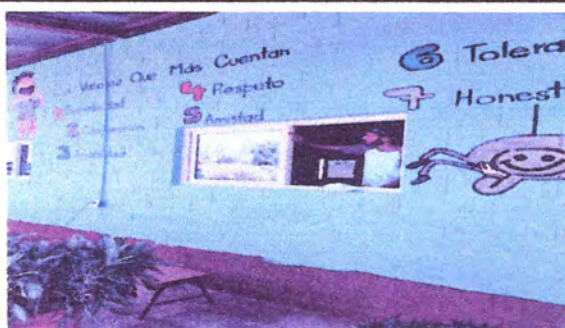
Foto: 5 Instalación de Ventanas
