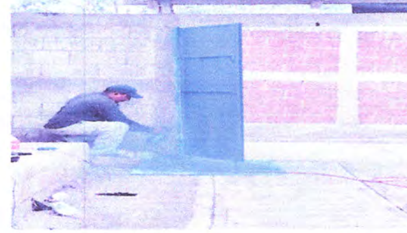
Foto4: Mantenimiento pintura porton
