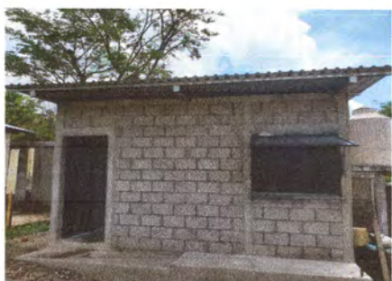
Foto1: Cubierta de lámina finalizada.
