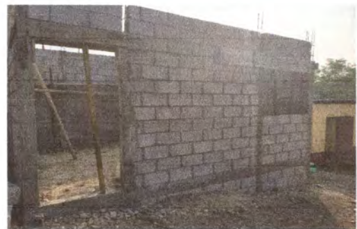
Foto 4: Reparación de muros de contención finalizado.
