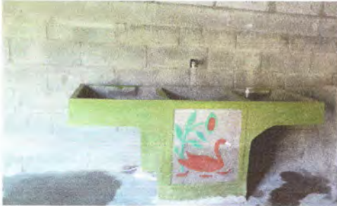
Foto 1: Reparación de red de drenajes y red de agua potable finalizado.
