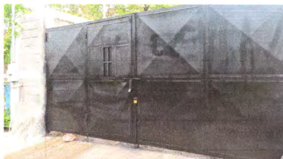
Foto 6: Mantenimiento a portonones finalizado.
