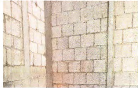
Foto 2: Cerco o muro perimetral finalizado.
