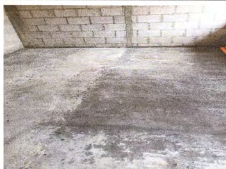
Foto 4: piso de cemento finalizado
