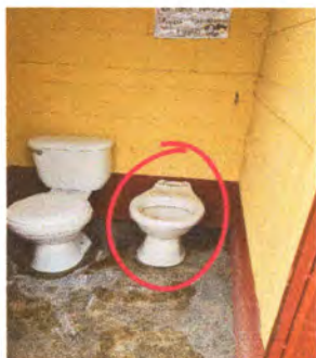
Foto 5: Servicios sanitarios y sus accesorios en proceso.
