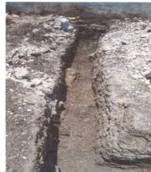
Foto 4: Reparación de muros de contención en proceso.
