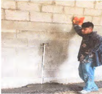
Foto1: Reparación de red de drenajes y red de agua potable en proceso.
