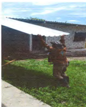
Foto1: Cubierta de lámina en proceso.
