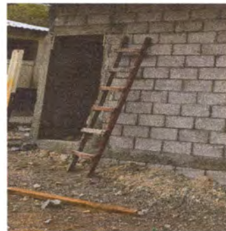
Foto 2: Puertas en proceso.
