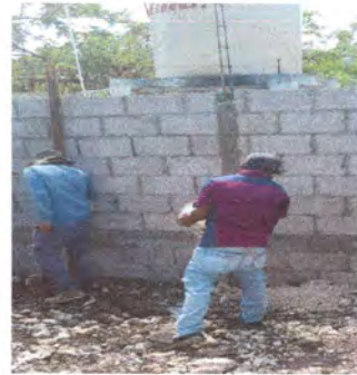
Foto 2: Cerco o muro perimetral en proceso.
