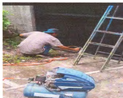
Foto 6: Mantenimiento a portonones en proceso.
