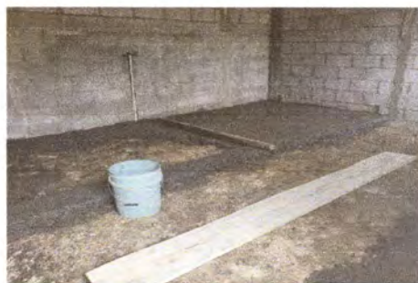
Foto 4: piso de cemento en proceso
