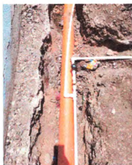
Foto: 5: REPARACION DE RED DE DRENAJES Y RED DE AGUA POTABLE
