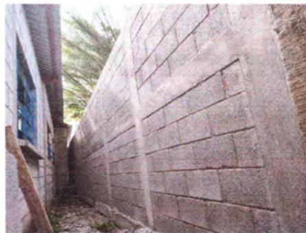
FOTO 2: CERCO O MURO PERIMETRAL
