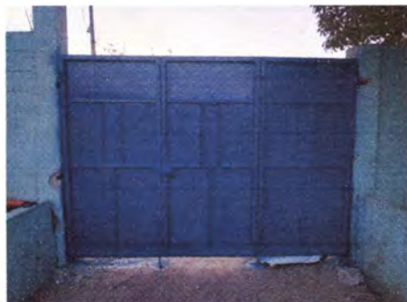
Foto3: MANTENIMIENTO DE PORTONES
