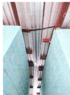
Foto: 6: COBERTURA DE LAMINA
