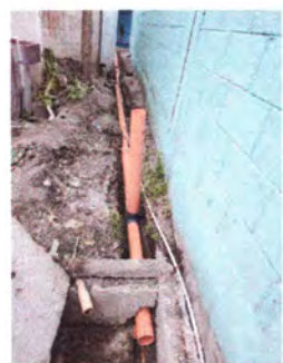
Foto: 5: REPARACION DE RED DE DRENAJES Y RED DE AGUA POTABLE
