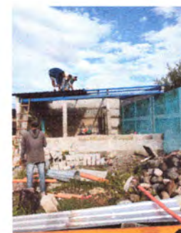
Foto: 6: COBERTURA DE LAMINA
