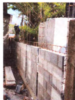
FOTO 2: CERCO O MURO PERIMETRAL
