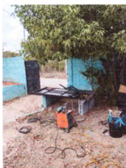
Foto3: MANTENIMIENTO DE PORTONES
