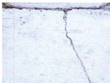
Foto 4: LOSA DE PATIO
