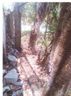
FOTO 2: CERCO O MURO PERIMETRAL
