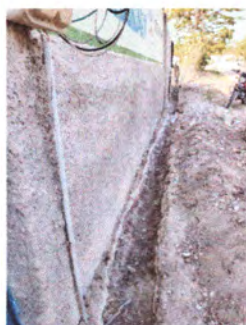
Foto 5: REPARACION DE DRENAJES Y RED DE AGUA POTABLE
