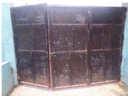
Foto 3: MANTENIMIENTO DE POSTONES
