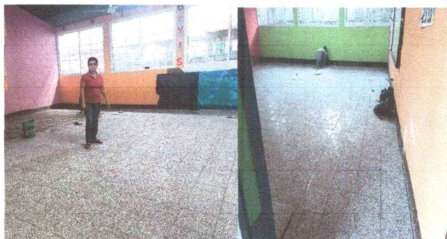
Foto 1: Sustrucción de piso de 3 aulas 7.40 x 8.50
