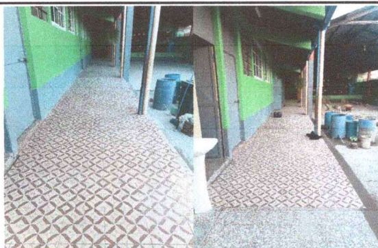
Foto 3: Piso de corredor 2.10 x 79.157.
