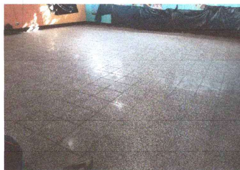
Foto 2: Sustrucción de piso de 3 aulas 7.40 x 8.50
