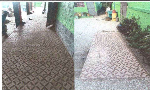
Foto 4: Piso de corredor 2.10 x 79.157.
