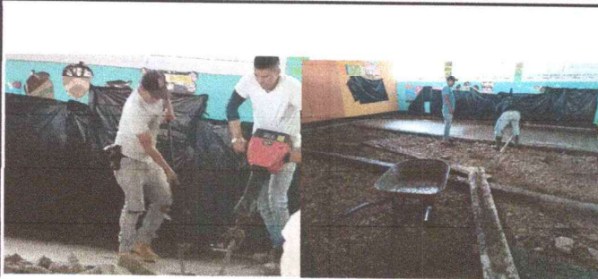
Foto 1: Sustitución de piso de 3 aulas 7.40 x 8.50
