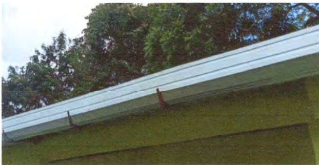
Foto3: Canales y bajadas de de agua pluviales instaladas
