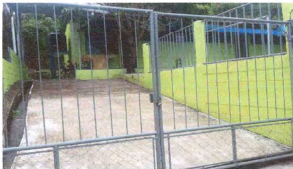
Foto: 5 Portones reparados
