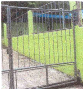
Foto: 5 portones en reparacion.
