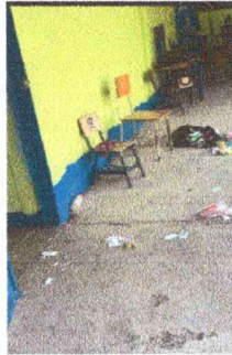
Foto4: pinturas de muros
