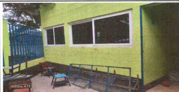
Foto 5: sustitucion de Ventanas
