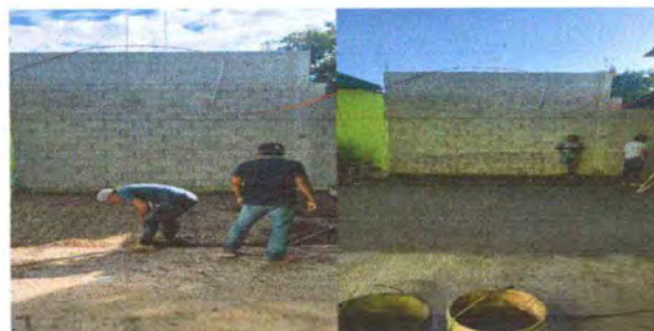
Foto 6: Sustitucion de losa de patio
