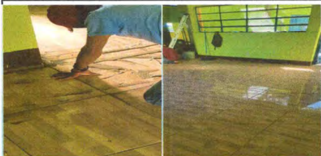
Foto1: Sustitucion de Piso
