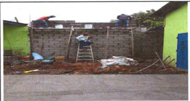
Foto 8: Levantado de muro perimetral
