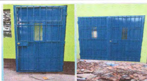
Foto 2: Sustitucion de Puertas
