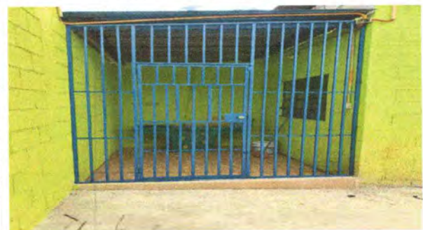
Foto 10: Reparacion de baranda
