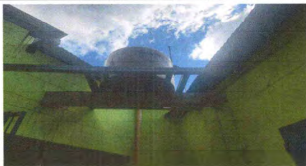
Foto 3: Reparación de base de concreto en Rotoplas
