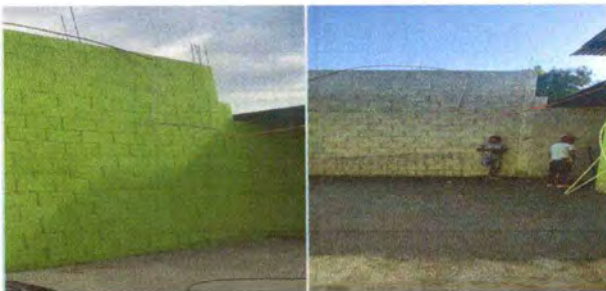
Foto 9: Pintura de muro perimetral
