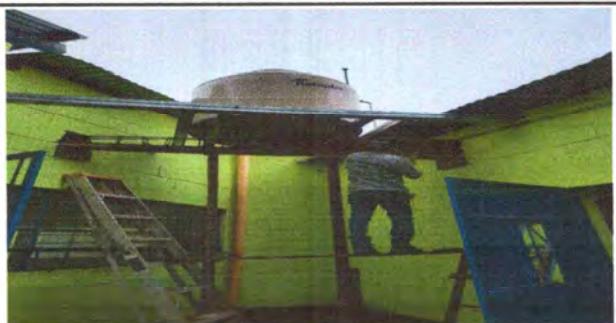
Foto 5: Reparacion base para Rotoplas
