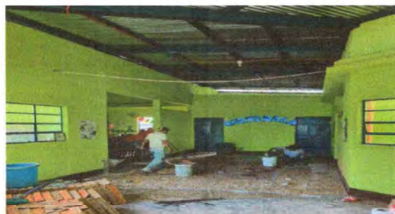
Foto 7: sustitucion de piso
