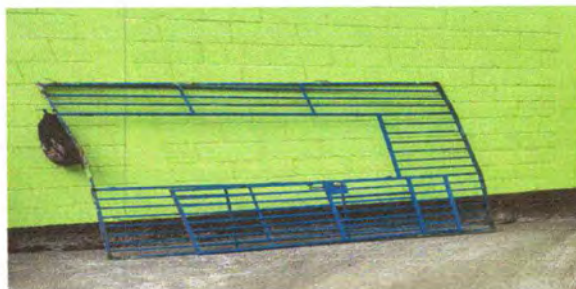
Foto 6: Reparacion de Baranda
