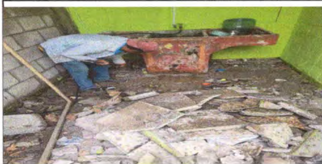
Foto 9: Sustitucion de Pila
