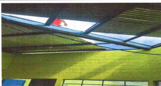
Foto 3: Reparación de cubierta de lamina
