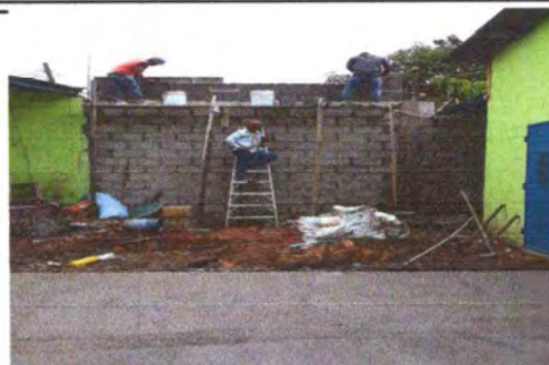
Foto 2: Levantado de Muro Perimetral
