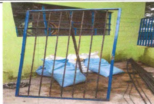
Foto 8: Sustitucion de Puertas
