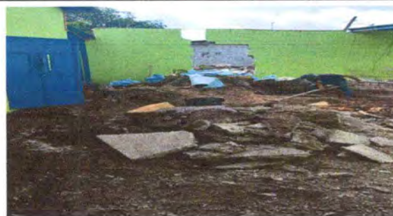
Foto 10: Sustitucion de losa de patio
