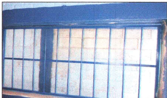
Foto 1: Sustitución de ventanas.
