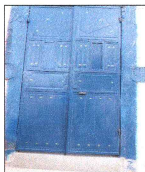
Foto 4: Sustitución de portón.
