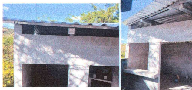
Foto 6: Reparación de área de cocina.
