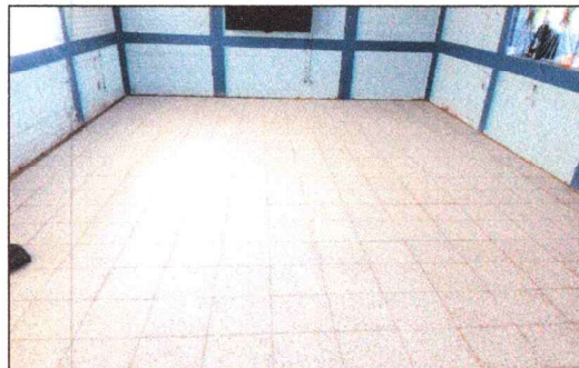
Foto 2: Sustitución de piso.
