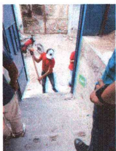
Foto 5: Sustrucción de losa de patio.
