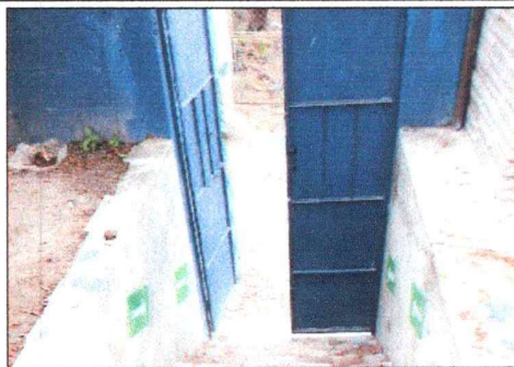
Foto 4: Sustrucción de portón.
