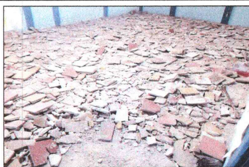
Foto 2: Sustrucción de piso.
