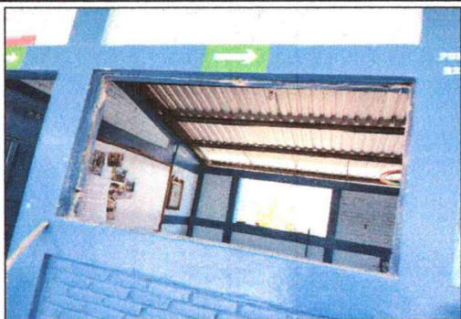
Foto 1: Sustrucción de ventanas.
