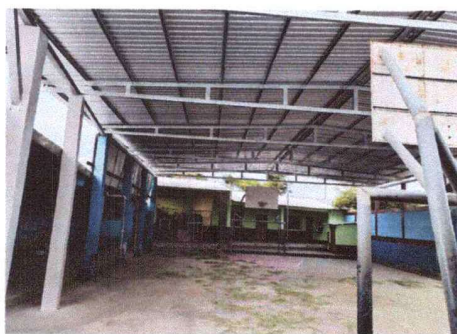
Foto 1: Finalización de cubierta de lámina
