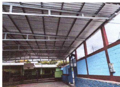
Foto 2: finalización de estructura de techo
