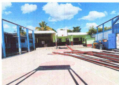
Foto 1: Retiro de Estructura de techo
