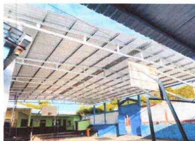
Foto 4: sustitución de lámina
