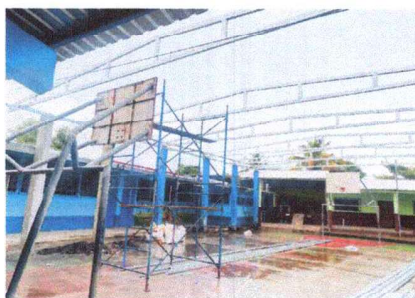
Foto 3: Sustitución de Estructura de techo
