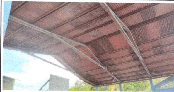
Foto 2: ESTRUCTURA DE TECHO
