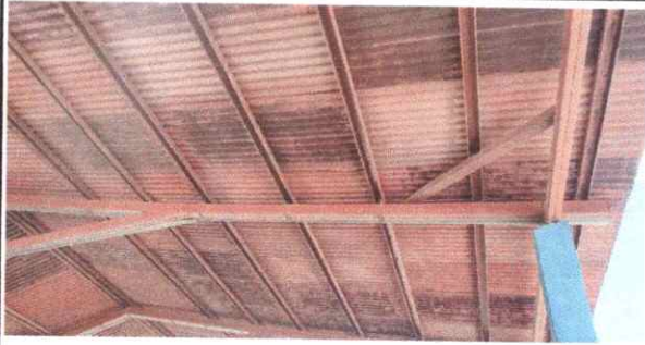
Foto 1: CUBIERTA DE LAMINA
