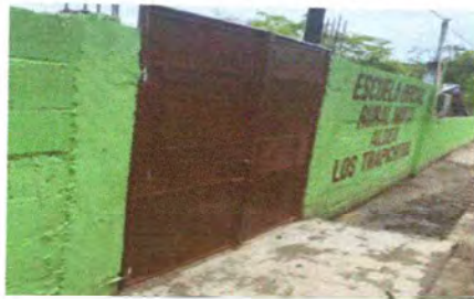
Foto 7: MANTENIMIENTO A PORTONES (REPARACION Y PINTURA).
