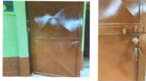
Foto 2: PUERTAS (REPARAR, PINTAR, CAMBIAR CHAPAS)
