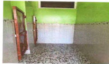
Foto 8: REPARACION O SUSTITUCION DE AZULEJO (SUSTITUCION).
