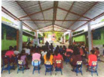
Foto 1: CUBIERTA DE LAMINA (SUSTITUCION LAMINA TROQUELADA CALIBRE 26)
