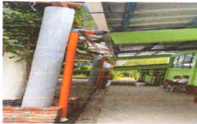
Foto 5: CANALES Y BAJADA DE AGUA PLUVIAL (CAMBIAR CANALES)
