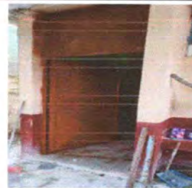
Foto 2: PUERTAS (REPARAR, PINTAR, CAMBIAR CHAPAS)
