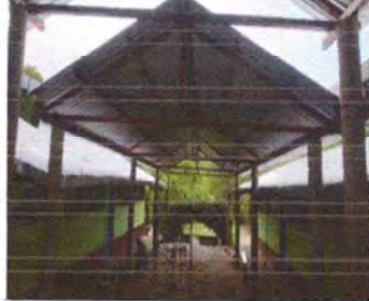
Foto 1: CUBIERTA DE LAMINA (SUSTITUCION LAMINA TROQUELADA CALIBRE 26)
