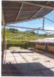
Foto 1: CUBIERTA DE LAMINA (SUSTITUCION LAMINA TROQUELADA CALIBRE 26)
