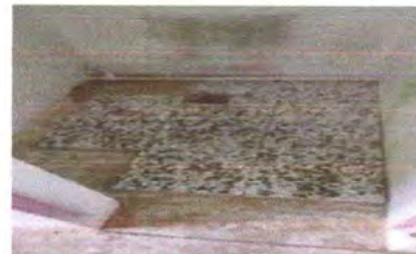
Foto 4: PISO (PISO DE GRANITO)
