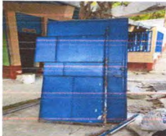
Foto 7: MANTENIMIENTO A PORTONES (REPARACION Y PINTURA).
