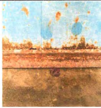
FOTO 2: Reparar, pintar y cambiar chapas
