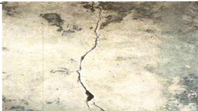
Foto 4: Sustitución a Piso de granito
