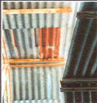
Foto 1: Cambio de lamina
