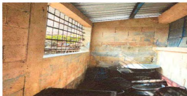
Foto 3: Cambio de 2 ventanas
