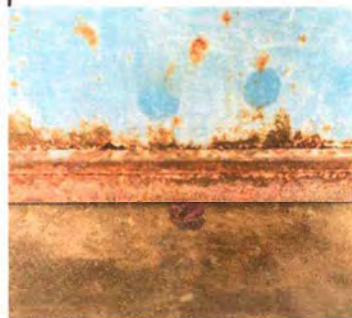
Foto 7: Reparación y pintura del porton
