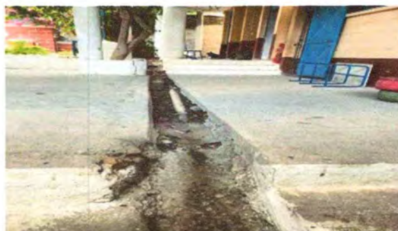
Foto: 6 Demoler y fundir las 2 cunetas
