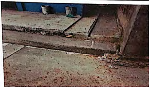
Foto1: protección de red de tubería del servicio de agua
