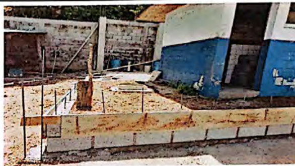
Foto 4: Reparación de Banqueta y caja terminal de drenaje
