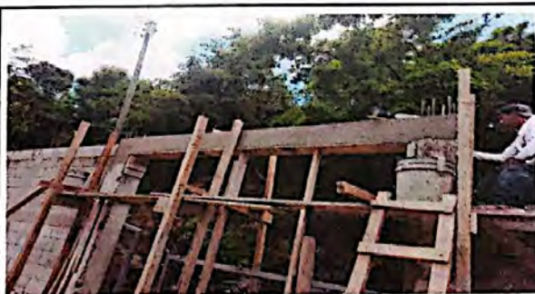
Foto 6: Reforzamiento y nivelación para el Porton Principal Escuela de Parvulos
