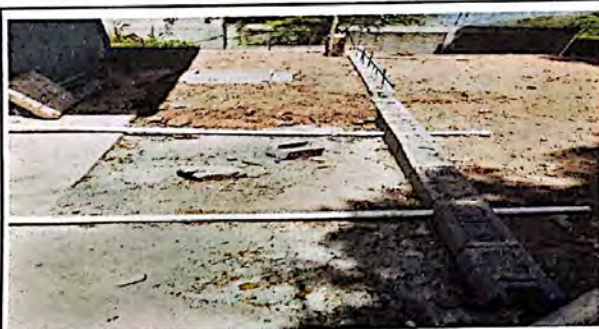
Foto 5: Reparación de Banqueta e instalación de tubería agua pluviales caja de drenaje
