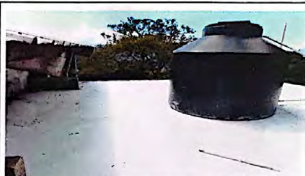
Foto 2: mantenimiento sistema de agua e impermeabilizador de loza
