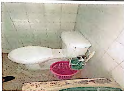
Foto 1: Reparación de Drenaje y cambio tazas para Baño
