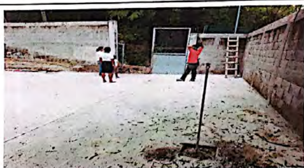
Foto 5: loza de patio Edificio en Pre primaria
