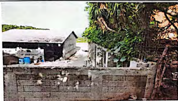
Foto 3: Reforzamiento muro de contención Edificio de parvulos
