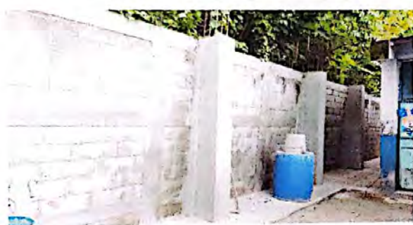
Foto 3: Reforzamiento de muro de contención
