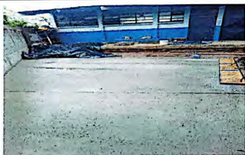
Foto 5: segundo tramo de 25 metros
