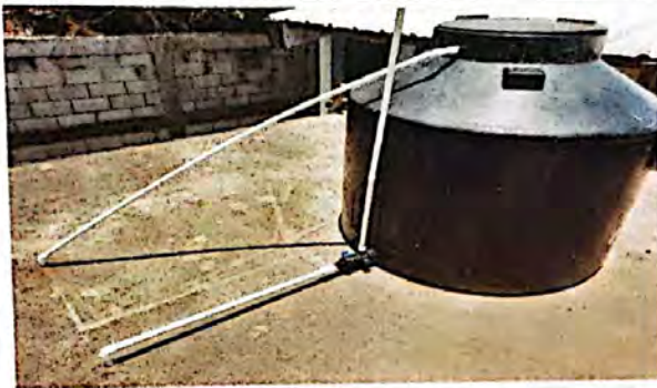
Foto1: Reparación de tubería agua potable y sistema
