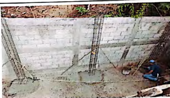
Foto 5: Peligro el derrumbre de paredes, paredes desaniveladas
