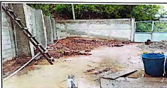
Foto 3: Reparación de muro de Contención
