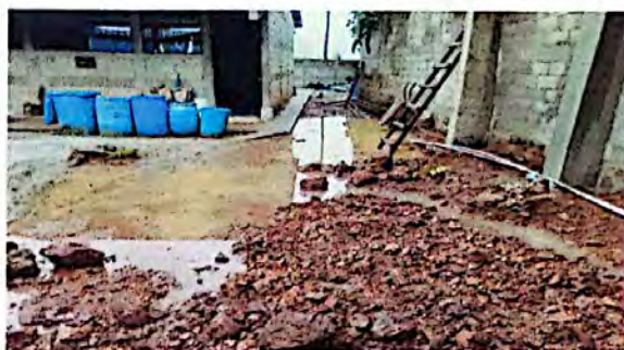
Foto 2: Nivelación del Terreno para loza de patio
