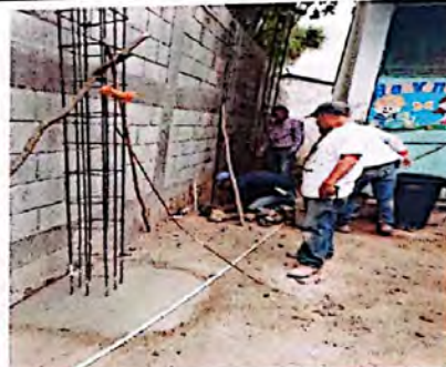
Foto 4: Reforzamiento 8 Muro de Contención
