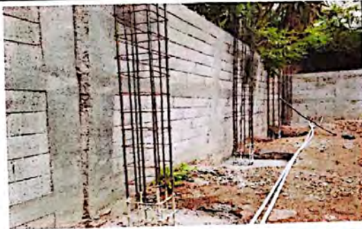
Foto 3: Reforzamiento de muro de Contención
