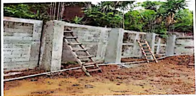
Foto 6: Tallado de muro de contención, para evitar deslave por lluvia.
