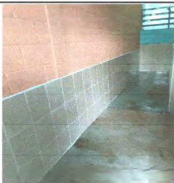
Foto 7: Cambio de azulejo por deterioro en algunas partes de los baños
