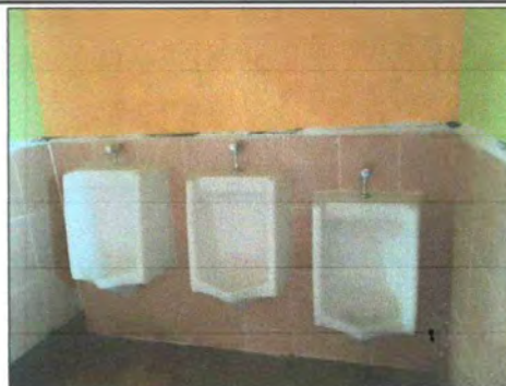
Foto 4: Cambio de migitorios, por deterioro
