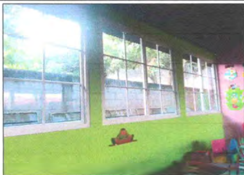
Foto 1: Cambio de ventanas, estructura metálica quebrada, no abren persianas, falta de ventilación
