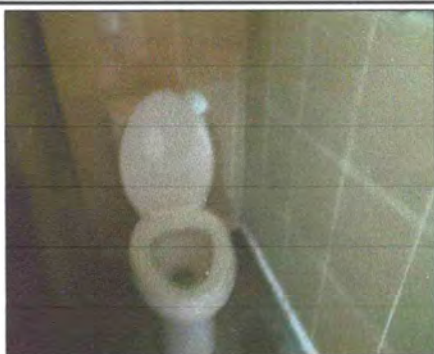
Foto 3: Cambio de sanitarios por deterioro.
