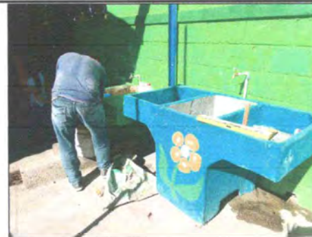
Foto 6: Cambio de pileta por deterioro y colocación de azulejo.
