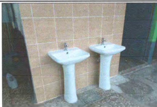
Foto 5 Cambio de lavamanos por deterioro.
