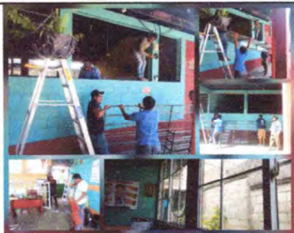
Foto 1: Cambio de ventanas, estructura metálica quebrada, no abren percerinas, falta de ventilación
