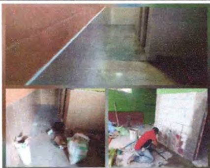
Foto 7: Cambio de azulejo por deterioro en algunas partes de los baños
