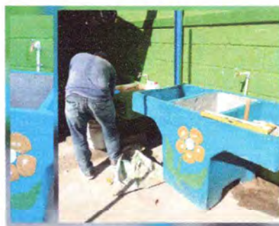
Foto 6: Cambio de pileta por deterioro y colocación de azulejo.
