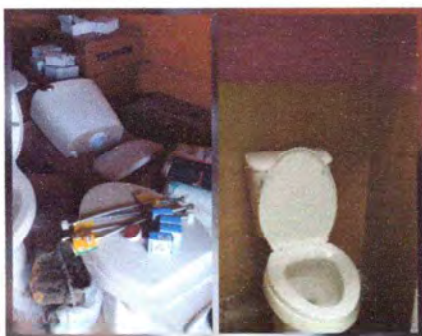
Foto 3: Cambio de sanitarios por deterioro.
