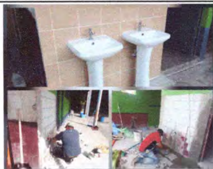
Foto: 5 Cambio de lavamanos por deterioro.
