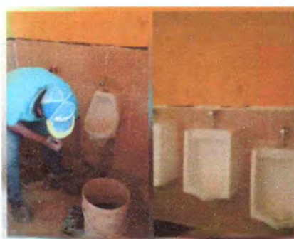
Foto 4: Cambio de migitorios, por deterioro
