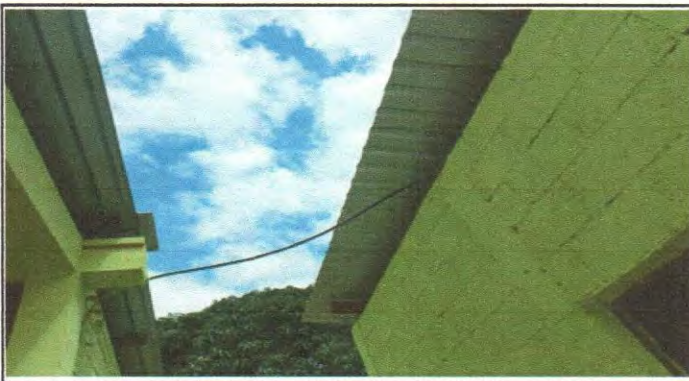
Reparación Sistema Eléctrico
