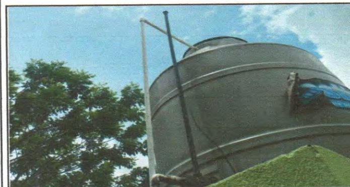
Reparación sistema depósito de agua
