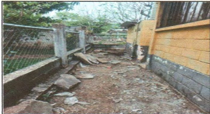
Reparación Losa de Patio
