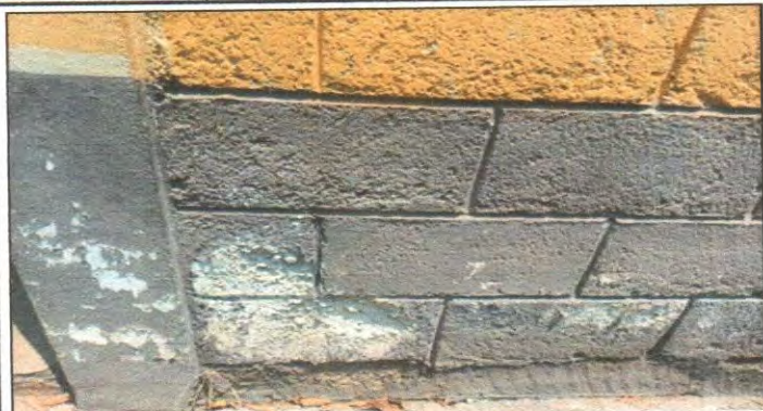
Reparación de repello y cernido de paredes
