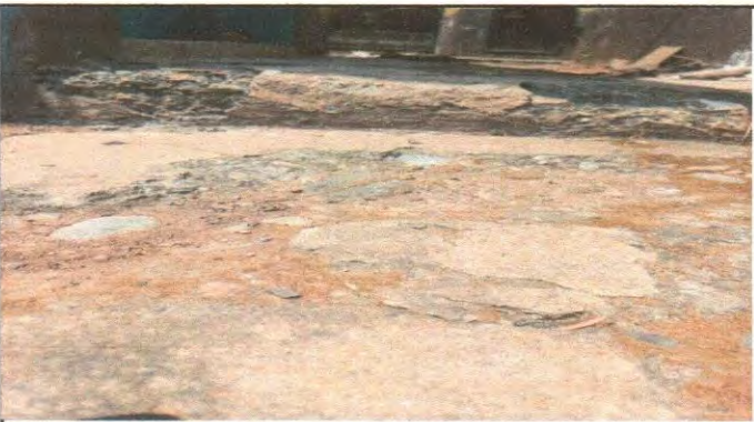
Reparación losa de patio
