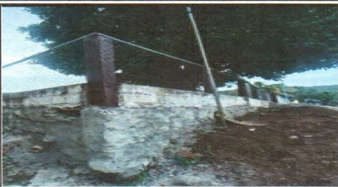
Cernido Muro Perimetral
