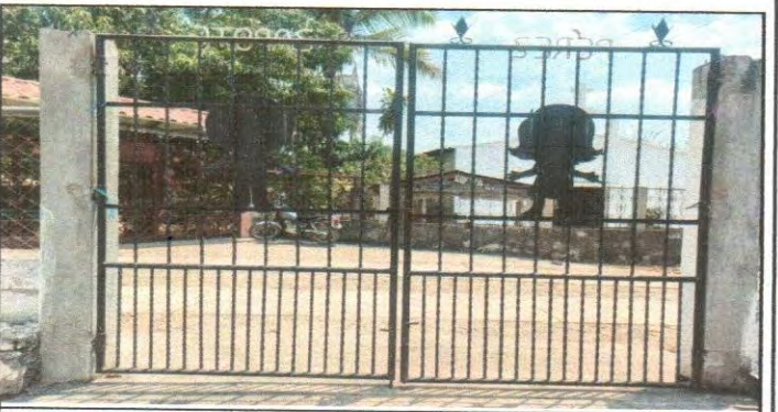
Pintura en porton
