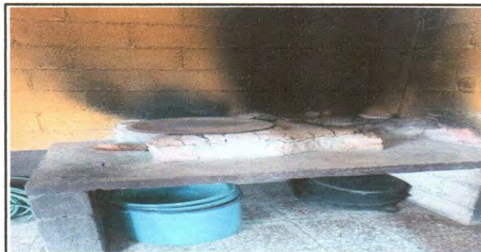
Reparación área de cocina
