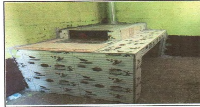
Reparación área de cocina
