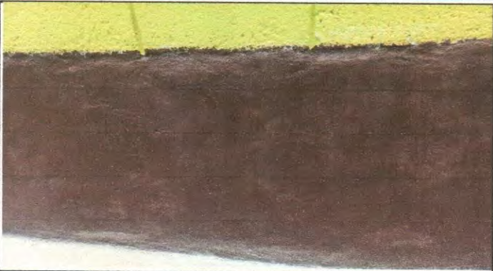
Reparación de repello y cernido de paredes
