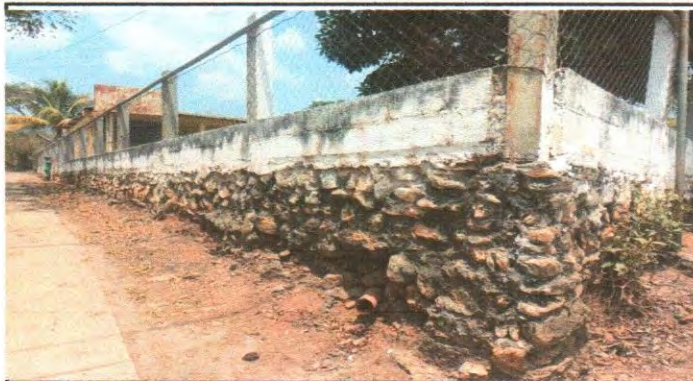
Cernido muro perimetral
