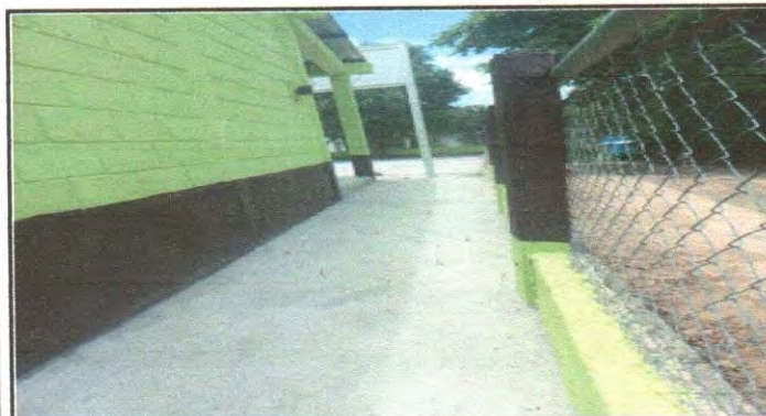
Reparación losa de patio
