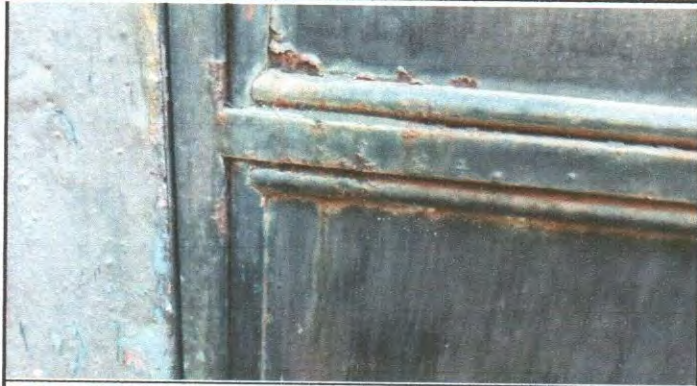
Reparación y pintura para puertas
