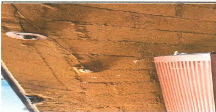
Reparación Sistema Eléctrico
