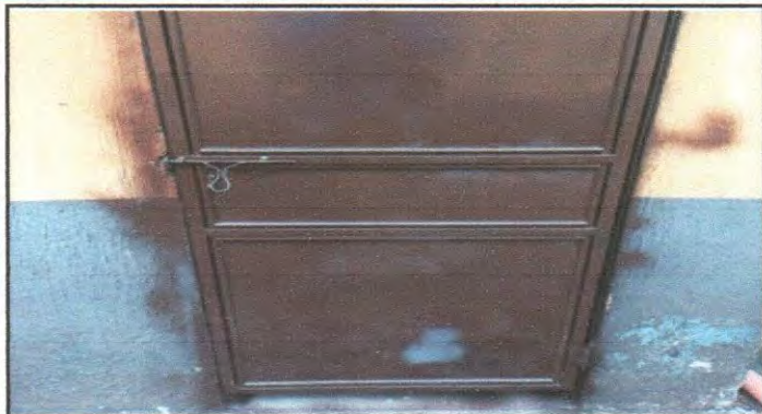
Reparación y pintura para puertas
