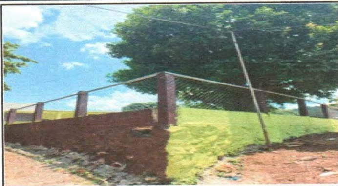
Cernido muro Perimetral
