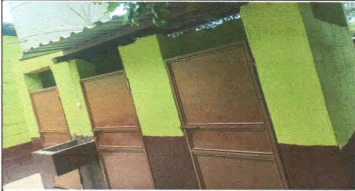
Reparación y pintura para puertas
