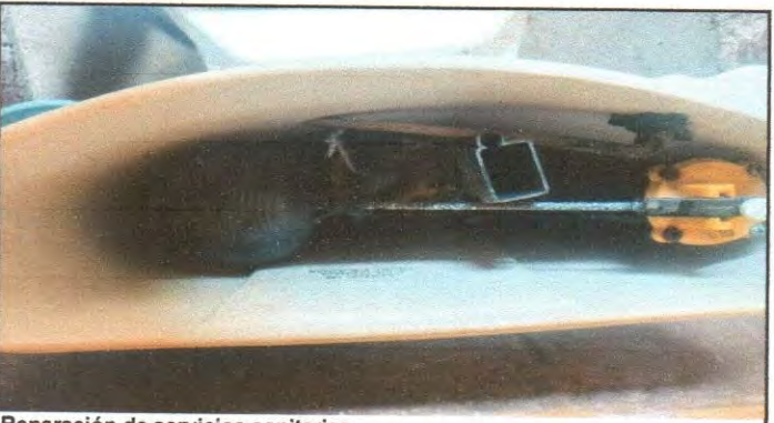
Reparación de servicios sanitarios
