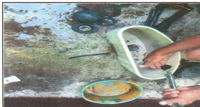
Reparación de servicios sanitarios
