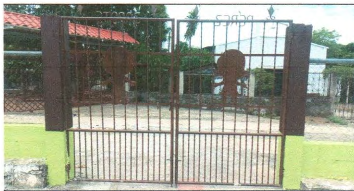
Pintura en porton
