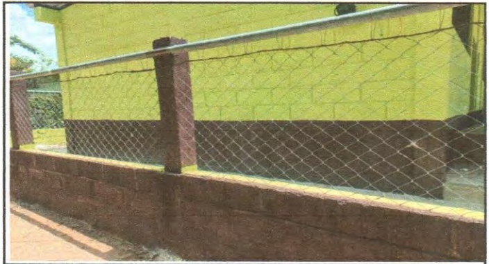
Pintura en muro interior y exteriores
