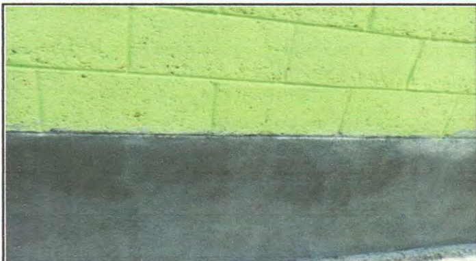
Repación de repello y cernido de paredes
