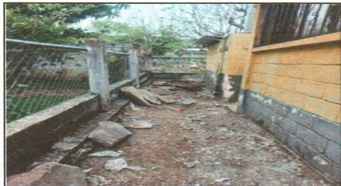
Reparación Losa de Patio
