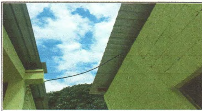
Reparación Sistema Eléctrico
