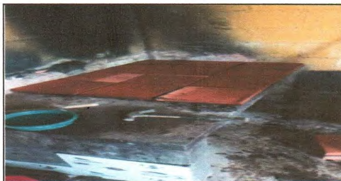
Reparación área de cocina
