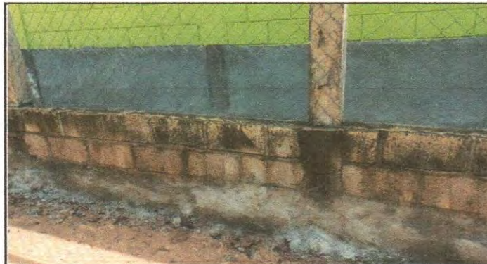
Pintura en muro interior y exteriores
