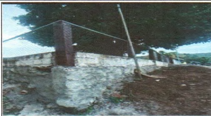
Cernido Muro Perimetral
