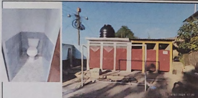
Foto 1: REPARACIÓN Y AMPLIACIÓN DE BAÑOS (Incluye reparación de losa, instalación de accesorios inodoro, contra llave, tubo de abasto, kit de tanque y puertas)
