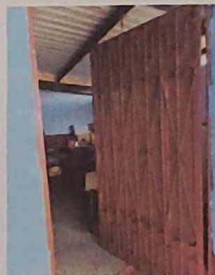
Foto 4: REPARACIÓN DE PUERTAS (Incluye lijado, cepillado, sujeciones, aplicación de 2 manos de pintura anticorrosiva)
