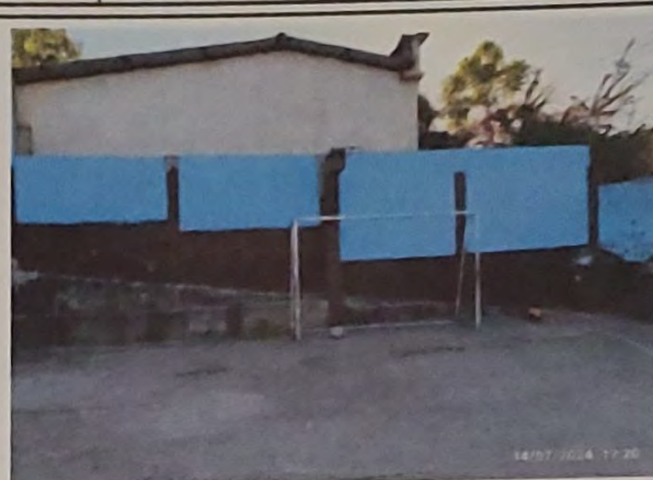
Foto 2: REPARACIÓN DE MURO PERIMETRAL
