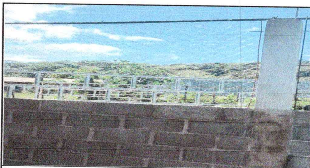
Foto 5: CERCO O MURO PERIMENTAL
