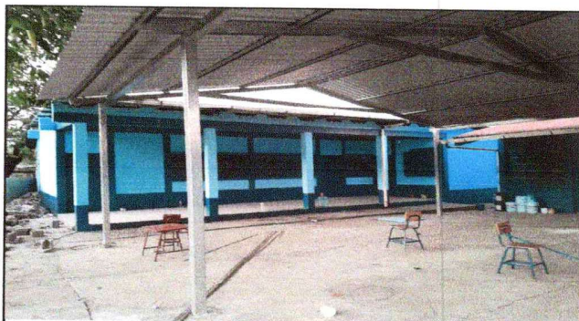
Foto 3: PINTURA EN MUROS INTERIOR Y EXTERIOR
