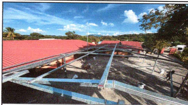
Foto 2: ESTRUCTURA DE TECHO
