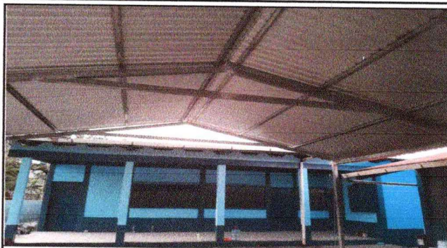
Foto 1: CUBIERTA DE LAMINA
