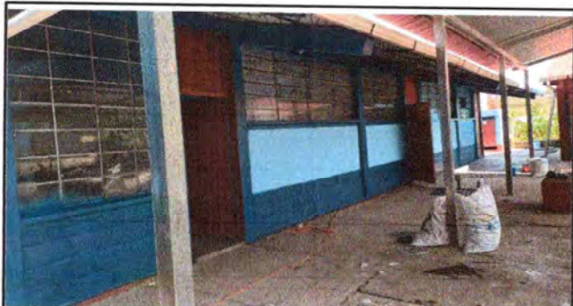
Foto 3: PINTURA EN MUROS INTERIOR Y EXTERIOR
