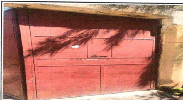
Foto 4: SUSTITUCIÓN DE PORTON CON TUBO Y LAMINA LISA
