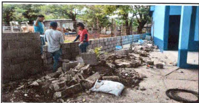
Foto 5: CERCO O MURO PERIMETRAL
