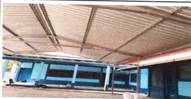
Foto 1: CUBIERTA DE LAMINA
