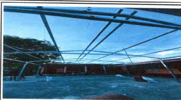
Foto 2: ESTRUCTURA DE TECHO
