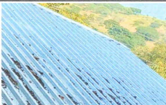
Foto1: Cubierta de lamina instalada
