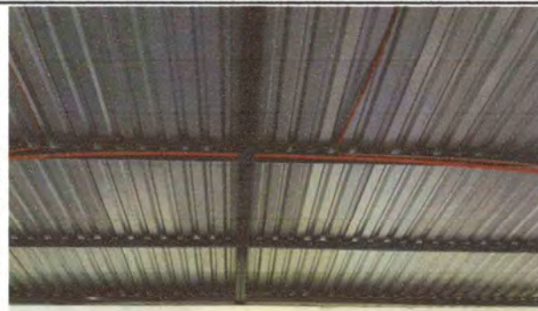
FOTO 2: Estructura de techo instalada
