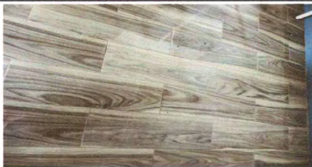
Foto3: Sustitucion de piso ceramica terminada
