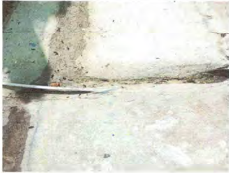
Foto 7: Red de drenajes y red de agua potable terminado
