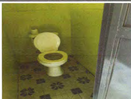
Foto: 5 Servicios sanitarios y accesorios instalados
