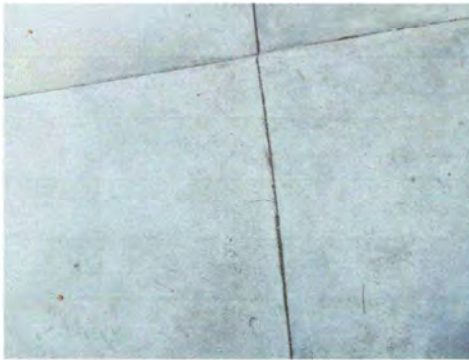
Foto 9 : Losa de patio terminado
