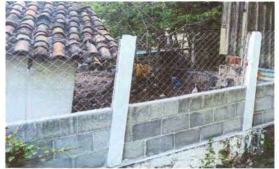
FOTO 8: Cerco o muro perimetral terminado
