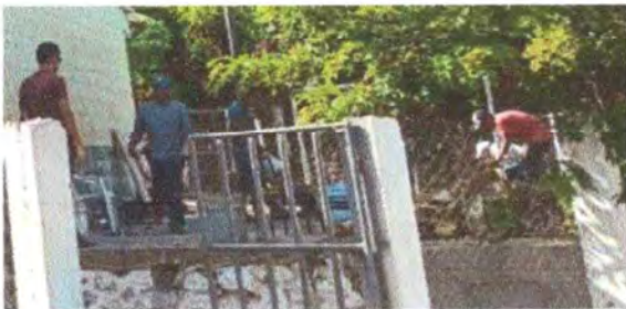
Foto9. reparación delosa de patio
