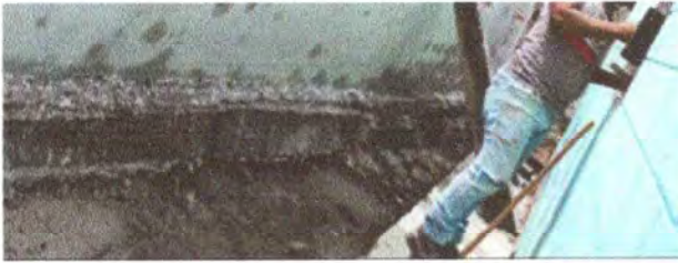
Foto. 7 reparando el drenaje
