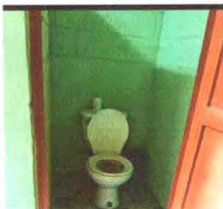
Foto: 5 reparacion de inodoro
