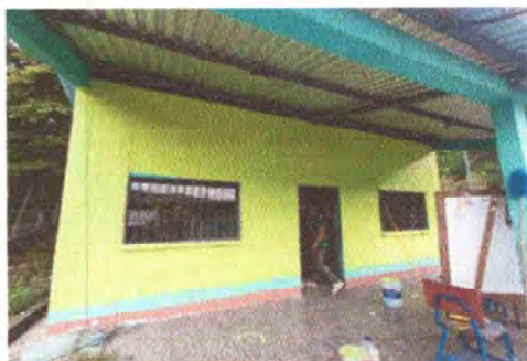
Foto4: pinturas de muros
