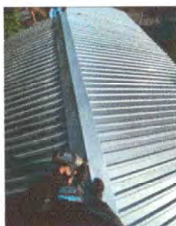
Foto1: cubierta de lamina
