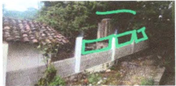
FOTO 8. reparando cerco o muro perimetral
