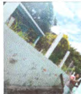
Foto:12 reparacion de relleno y cernido
