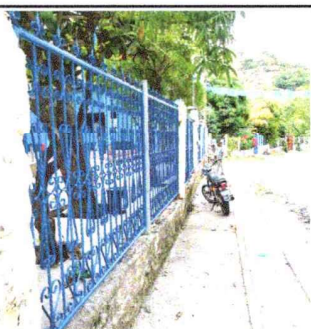
Foto 5: Sustitución de barandas
