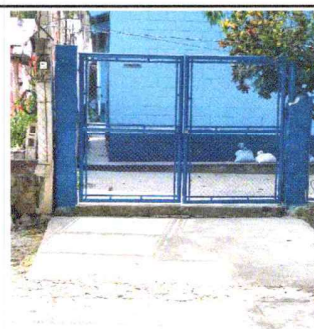
Foto 6: Sustitución de portón
