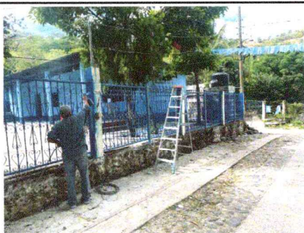
Foto 5: Sustitución de barandas
