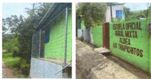
Foto 6: CERCO O MURO PERIMETRAL (DEMOLICION, LEVANTADO Y CAMBIO DE MALLA).
