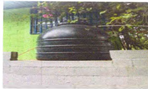
Foto 8: REPARACION Y MANTENIMIENTO DE DEPOSITO DE AGUA.
