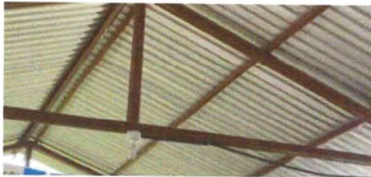
Foto 7: REPARACION DEL SISTEMA ELECTRICO.
