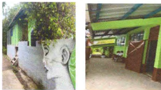
Foto 2: PINTURA EN MUROS INTERIOR Y EXTERIOR
