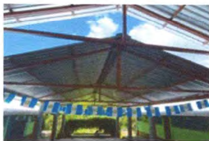
Foto1: ESTRUCTURA DE TECHO (DESMONTAR, PINTAR Y AGREGAR TIJERAS)
