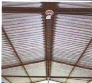
Foto 7: REPARACION DEL SISTEMA ELECTRICO.
