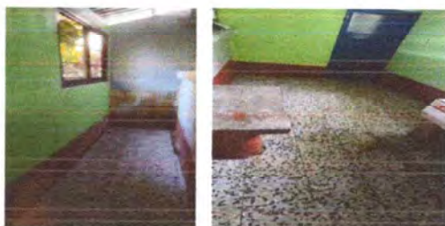
Foto 9: REPARACION O SUSTITUCION DE AREA DE COCINA.
