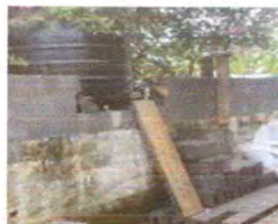
Foto 8: REPARACION Y MANTENIMIENTO DE DEPOSITO DE AGUA.
