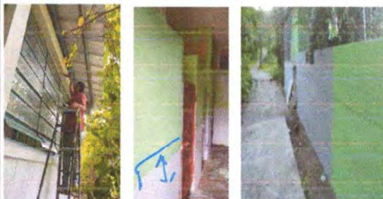
Foto 2: PINTURA EN MUROS INTERIOR Y EXTERIOR
