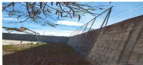
Foto 6: CERCO O MURO PERIMETRAL
