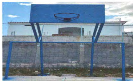
Foto 4: PINTURA MURO INTERIOR Y EXTERIOR
