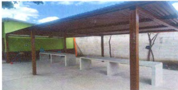
Foto7: LOSA DE PATIO
