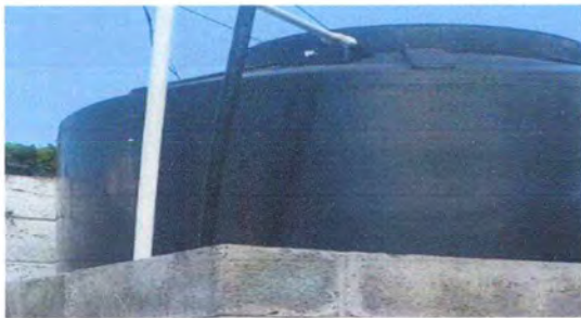
Foto 9: SUSTITUCIÓN DE ROTOPLAS
