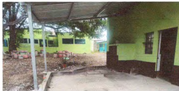
Foto 2: SUSTITUCIÓN ESTRUCTURA DE TECHO
