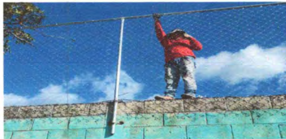
Foto 6: CERCO O MURO PERIMETRAL
