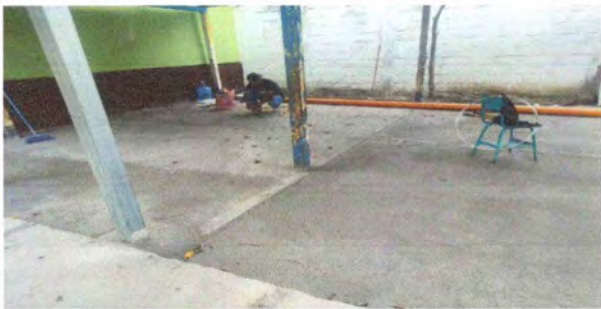
Foto 7: LOSA DE PATIO
