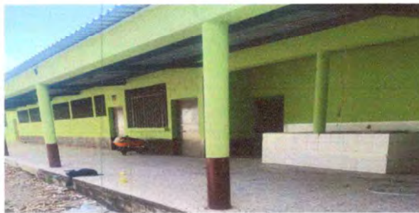
Foto 4: PINTURA MURO INTERIOR Y EXTERIOR
