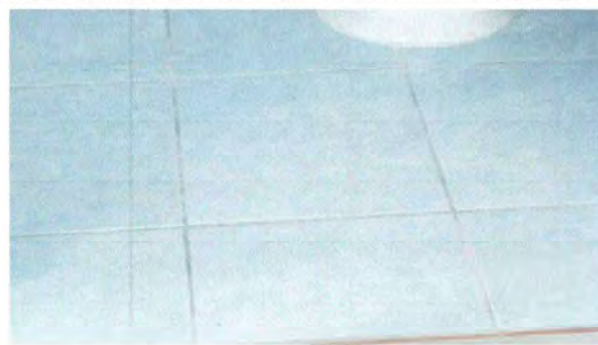
FOTO 2: Piso cerámica instalado
