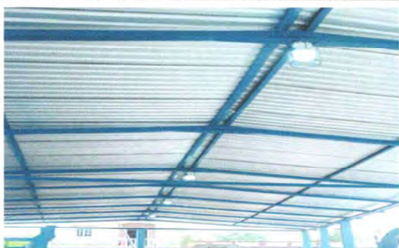
Foto 7: Sistema electrico instalado.
