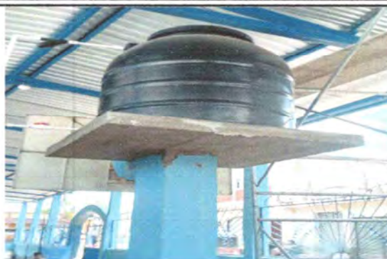
FOTO : 8 Depósito de agua instalado.
