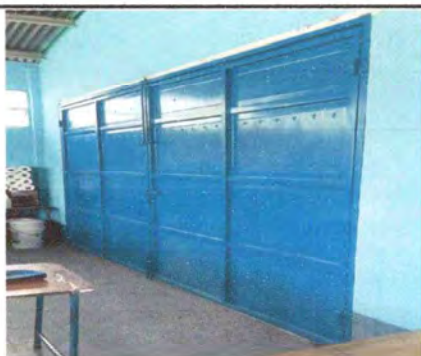
Foto: 5 Porton Instalado
