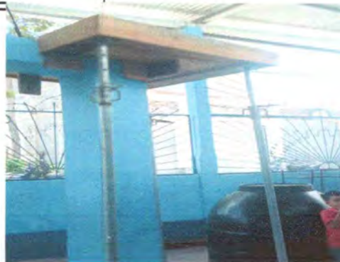
FOTO: 8 Instalación depósito de agua.
