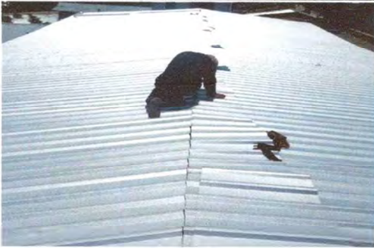
Foto 1: Colocación de lámina en techo
