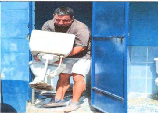
Foto 3: Instalación de sanitario.
