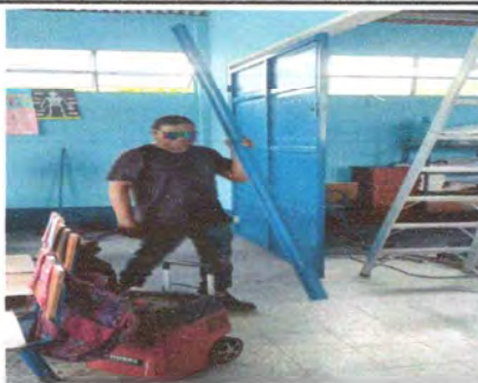
Foto: 5 Instalación de porton.
