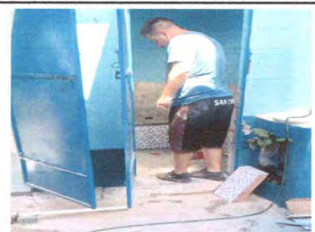
Foto: 6 Colocación de azulejo en sanitario.
