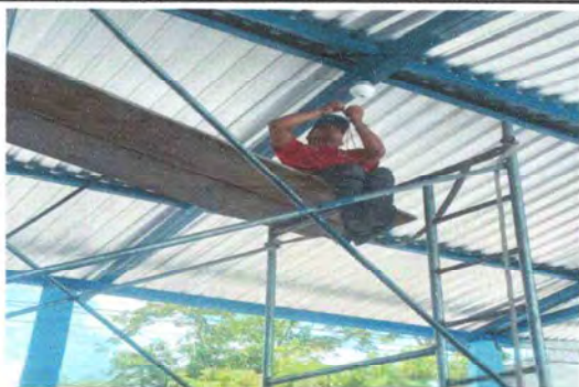
Foto 7: Instalación Sistema Eléctrico.
