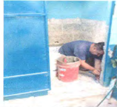
FOTO 2: Sustitución de piso ceramico en sanitario.
