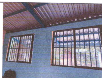
Foto 4: venanas y balcones instalados
