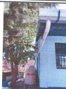
Foto 2: Canales y bajadas instaladas
