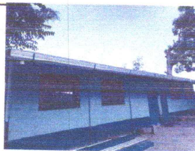
Foto 6: sustitución de ventanas y balcones.
