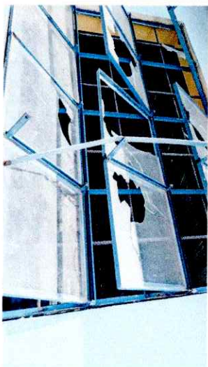
Foto 8: SUSTITUCIÓN DE VENTANAS
