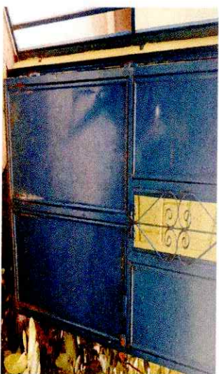
FOTO 1: SUSTITUCIÓN DE PUERTAS
