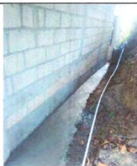
Foto 5: CUNETETA DE CONCRETO
