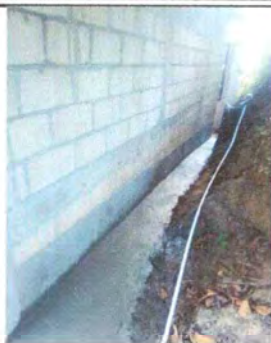
Foto 7: REPARACIÓN DE DRENAJE Y AGUA POTABLE
