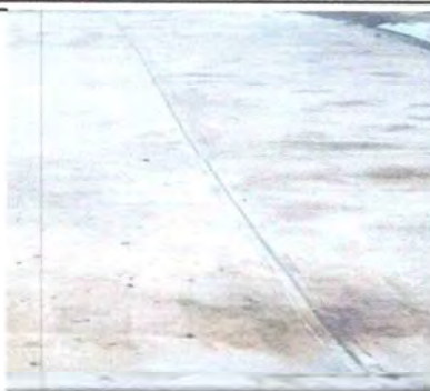
Foto 8: LOSA DE PATIO
