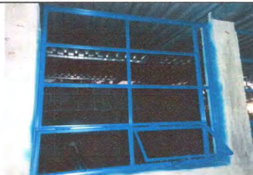
Foto 4: SUSTITUCIÓN DE VENTANAS
