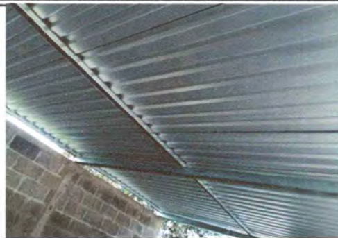
Foto 2: SUSTITUCIÓN ESTRUCTURA DE TECHO
