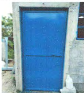
Foto 3: REPARACIÓN, SUSTITUCIÓN Y MANTENIMIENTO DE PUERTAS
