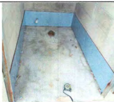
Foto 7: REPARACIÓN DE DRENAJE Y AGUA POTABLE
