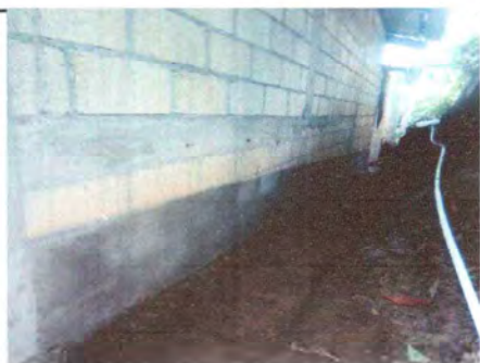
Foto 5: CUNETA DE CONCRETO
