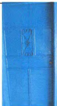
Foto 3: REPARACIÓN, SUSTITUCIÓN Y MANTENIMIENTO DE PUERTAS
