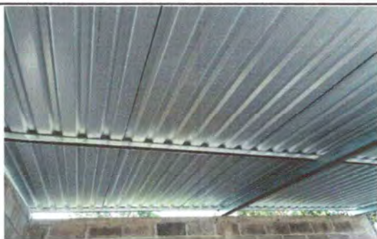
Foto 1: SUSTITUCIÓN DE LAMINA
