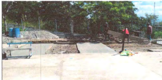
Foto 8: LOSA DE PATIO
