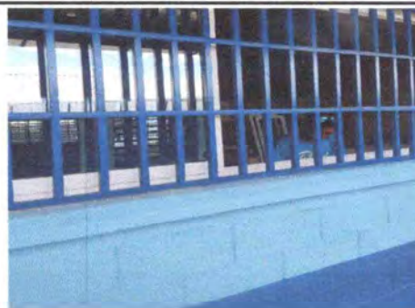
Foto 4: Pintura en muro interior y exterior del area de cocina.
