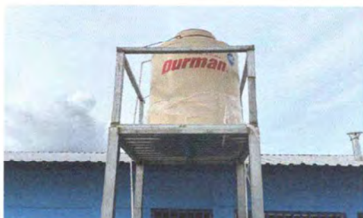
Foto 9: Mantenimiento y depósito de agua instalado
