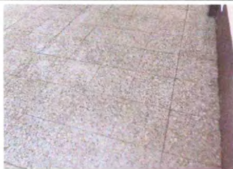
Foto 3: Piso de granito instalado
