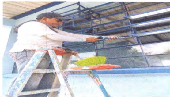
Foto 2: Sustitución de vidrios
