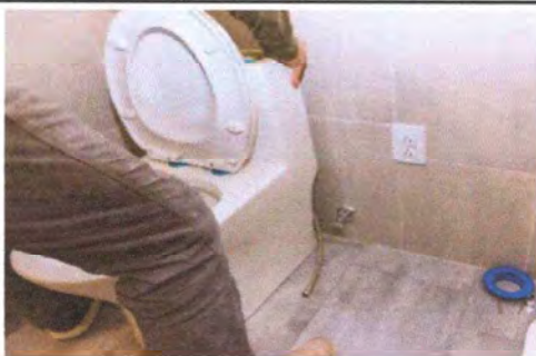
Foto 5: Instalación de sanitario
