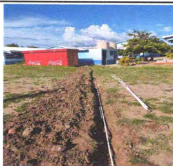
Foto 7: Instalación de red de drenaje
