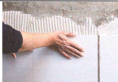
Foto 6: Cambio de azulejo
