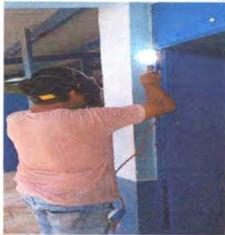
Foto1: Colocación de puertas
