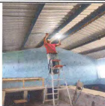
Foto 8: Instalación de sistema eléctrico
