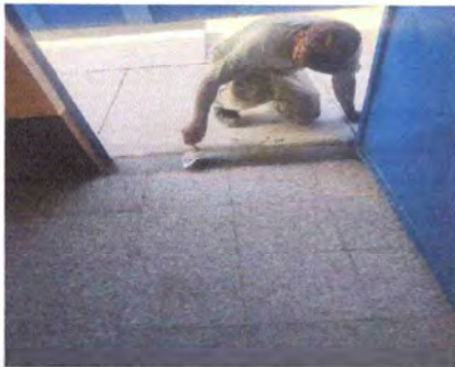
Foto 3: Sustitución de piso en área de cocina
