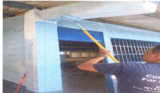
Foto 4: Pintura en muros interiores y exteriores
