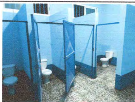
Foto 2: piso de granito colocado en los servicios sanitarios del establecimiento.
