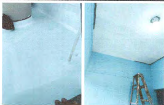
Foto1: terraza impermeabilizada con los materiales adecuados para su protección.
