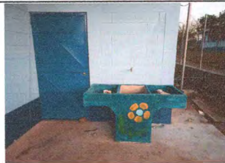
Foto 6: pila colocada de manera adecuada.
