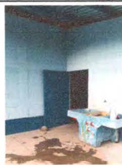
Foto 6: reemplazo de pila.
