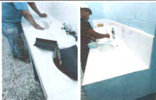
Foto 3: reparación y mantenimiento de lavamanos y servicios sanitarios.
