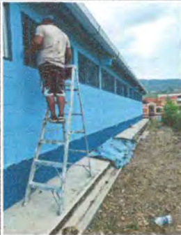
Foto 7: Colocación de Pintura a base de agua y aceite.
