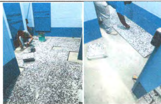
Foto 2: Colocación de Piso de Granito.
