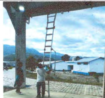
Foto 4: reemplazo de lamparas en las instalaciones.
