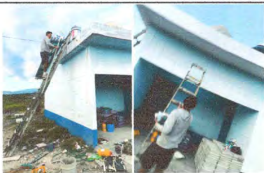
Foto1: Impermeabilización de Terraza
