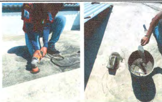
Foto 5: colocacion de base para sistema de distribucion de agua en las instalaciones.
