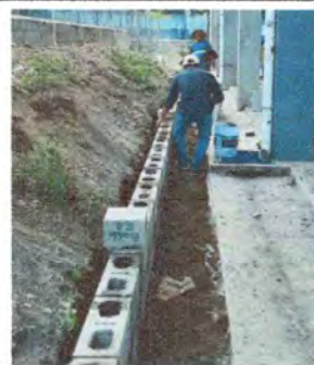
Foto 8: colocacion de muro en cuneta.
