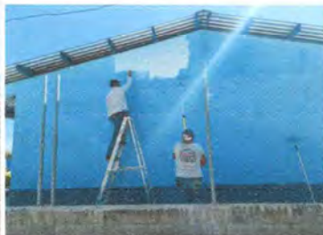
Foto 7: Colocación de Pintura a base de agua y aceite.
