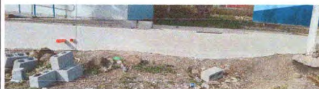
Foto 10: MURO DE CONTENCIÓN FINALIZADO.
