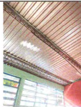
Foto 2: CUBIERTA DE TECHO FINALIZADO.
