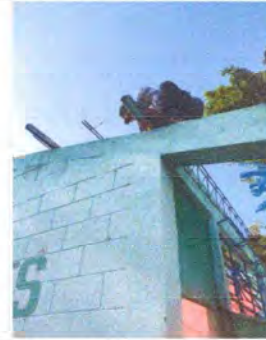
Foto 2: AVANCE DE CUBIERTA DE TECHO EN PROCESO.
