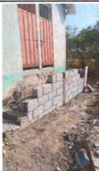
Foto 7: AVANCE DE SANITARIOS EN PROCESO.
