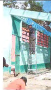
Foto 4: AVANCE DE VENTANAS EN PROCESO.
