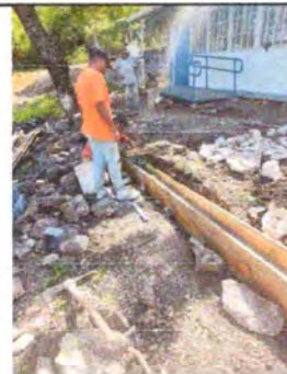
Foto 10: AVANCE DE MURO CONTENCIÓN EN PROCESO.
