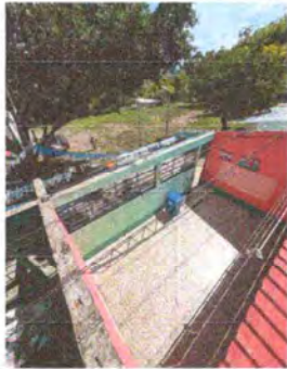
Foto1: AVANCE DE CUBIERTA DE LAMINA EN PROCESO.
